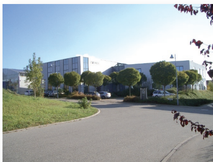
Das Firmengebäude der HUR Deutschland GmbH (Foto: HUR)
